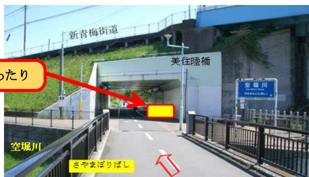
美住陸橋手前から進行方向（八坂駅方向）を見た写真
